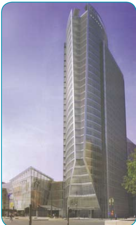
La première pierre de la future tour Oxygène a été posée le 29 mars
