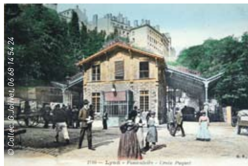
La gare du funiculaire créée en 1885, inaugurée en 1891, aujourd'hui station Croix Paquet de la ligne C.
