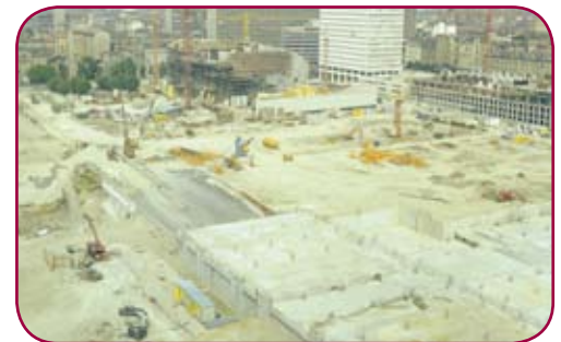
Construction du centre commercial et de l'Auditorium
