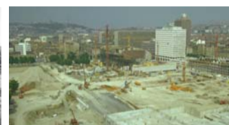
Construction du centre commercial en 1973
