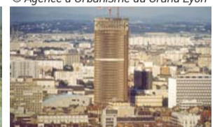
Chantier de la tour du Crédit Lyonnais en Janvier 1977
